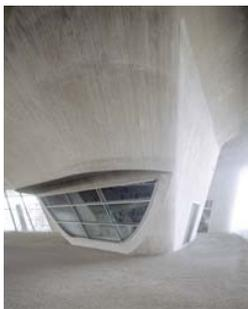
Abb. 3.10: Zaha Hadid: Phaeno, Wolfsburg: Sogn. Konen tragen das Gebäude und bilden gleichzeitig Raum für Kioske, Treppenaufgänge etc.
