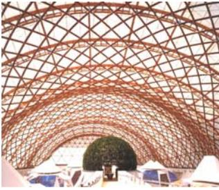
Abb. 3.11: Shigeru Ban Architects, Beratung Frei Otto: Japanischer Pavillon, Expo 2000, Hannover. Das Material bestimmt die Form: eine gewellte, gitternetzartige Tonnenschale aus Pappröhren, Karton und Papier [vgl. Flagge und Schneider]
