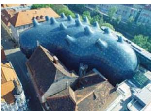
Abb. 3.8: Peter Cook und Colin Fournier: Kunstmuseum Graz „Spacelab“, 2004. Ein biomorphes Gebilde: In jeder Hinsicht ein formorientierter Entwurf, allein 1500 unterschiedlich geformte Kunststoffplatten bilden die hinterleuchtete Fassade. [Detail, 11/2003, S. 1252]
