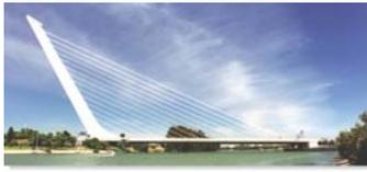
Abb. 3.48: Santiago Calatrava, Alamillo-Brücke, Sevilla, Spanien (1992) „... ist die einzige Schrägseilbrücke der Welt, die keine Rückverankerung hat.“ [Wikipedia]
