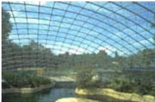
Abb. 3.12: Doppelgekrümmte Flächentragwerke: Die von Schlaich und Schöber vor etwa 10 Jahren entwickelten Translationsnetzschalen (TNS) knüpfen an die Palmenhäuser des 18. und 19. Jahrhunderts an. Die TNS bestehen aus ebenen, verglasten Vierecksmaschen, die mit Seil-diagonalen ausgesteift sind.
