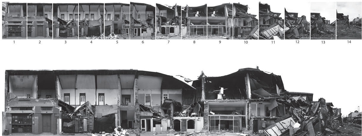
Fig. 3. Fotografía y su proceso de construcción. El edificio corresponde a la fachada suroeste del pasaje Aurelio Manzano en Concepción. Fue uno de los colapsados por el terremoto que estaban contruidos a base de ladrillo a principios del siglo XX. Impresa para De-hechos en un tamaño de 0,4x2 mts, la imagen final puede ser impresa a 1, 2x6 mts. que correspondería
