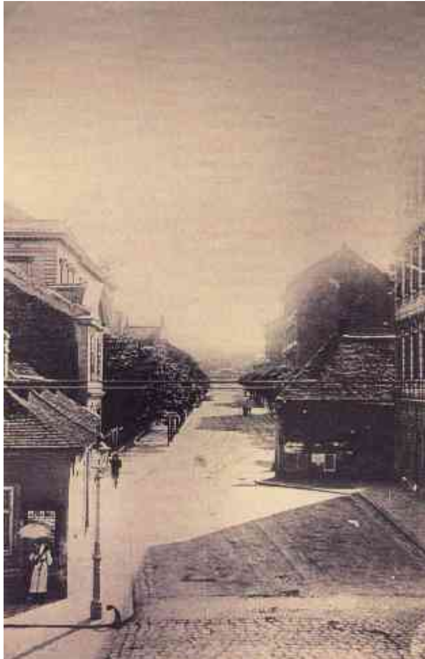
Abb. 10 Braunhubergasse /Simmeringer Hauptstraße um 1900 Synagogendach links im Hintergrund (Quelle: Privatarhiv Herbert Exenberger)
