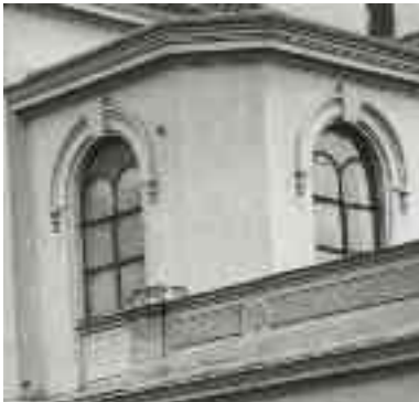
Abb. 26 Fotografie Detail Stiegenhausfenster
