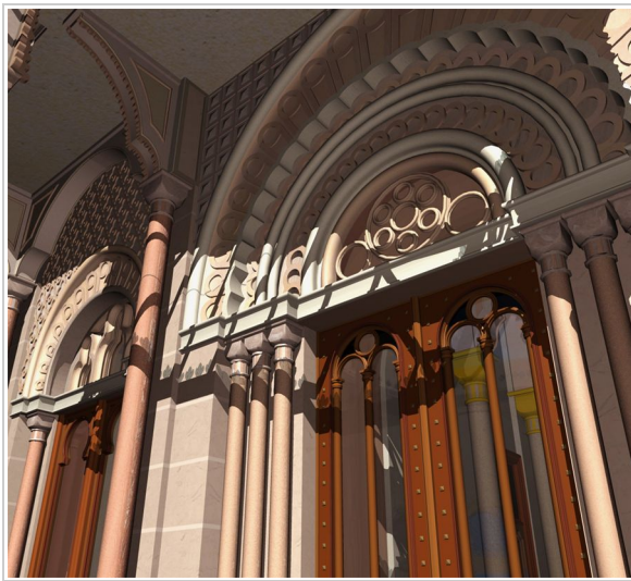
Abbildung 7.7.: Haupteingang der Synagoge.
