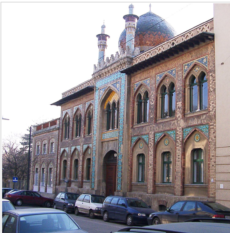
Abbildung 3.18.: Heutiges Bild der Fassade Nusswaldgasse 15-16, Wien-Döbling.
