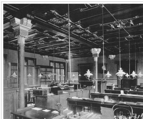
Abbildung 3.21.: Innenansicht eines Bürorraums der Fabrik Zacherl.
