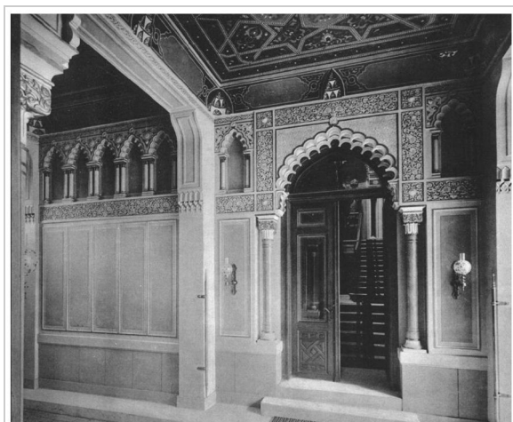
Abbildung 3.20.: Torbogen eines inneren Stiegenauftritts.
