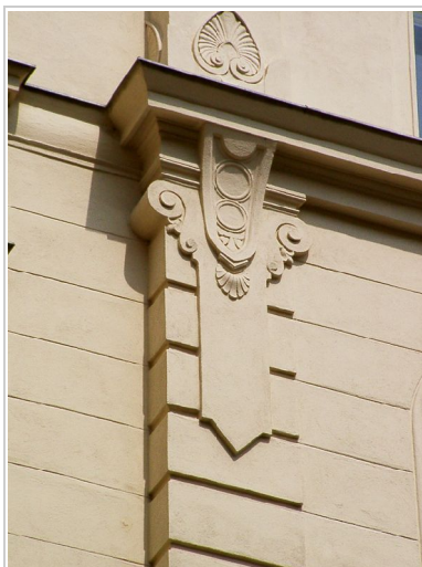
Abbildung 3.3.: Fassadendetail oberer Abschluss der Wandvorlage.
